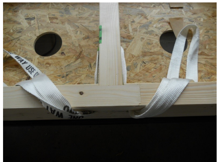
Fig. 3 – Sangle de levage préinstallée dans le mur SYBOIS avant fermeture du panneau et insufflation de la ouate de cellulose
