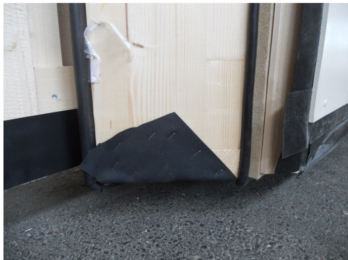
Fig. 1 - Détail de relevé de la bande de protection en extrémité de panneau de mur SYBOIS (ici mur d'angle avec coupe à 45°)
