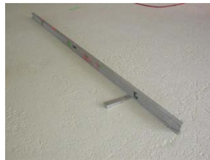
Une tolérance de 7 mm sous la règle de 2 m
