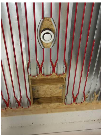
Figure 11 - Dévoiement autour d'un petit obstacle (bouche de VMC) et contournement d'une trappe ou d'une fenêtre de toit. (Sur un banc de formation)
