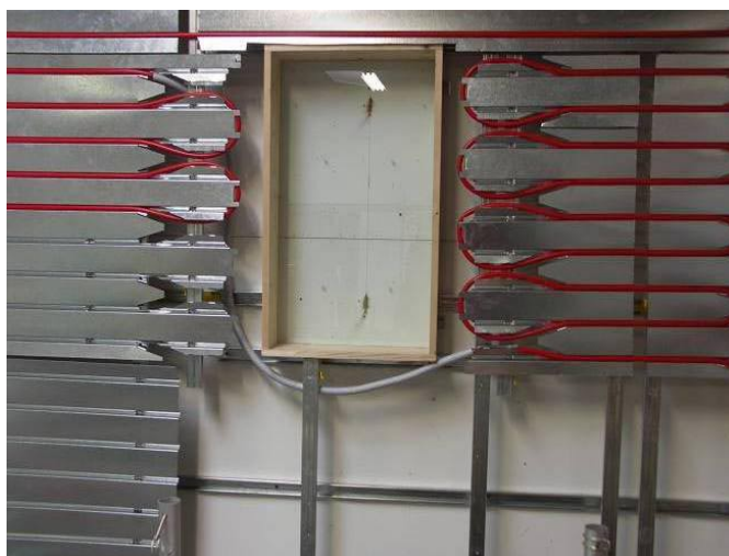
Figure 11 - Dévoiement autour d'un petit obstacle (bouche de VMC) et contournement d'une trappe ou d'une fenêtre de toit. (Sur un banc de formation)
