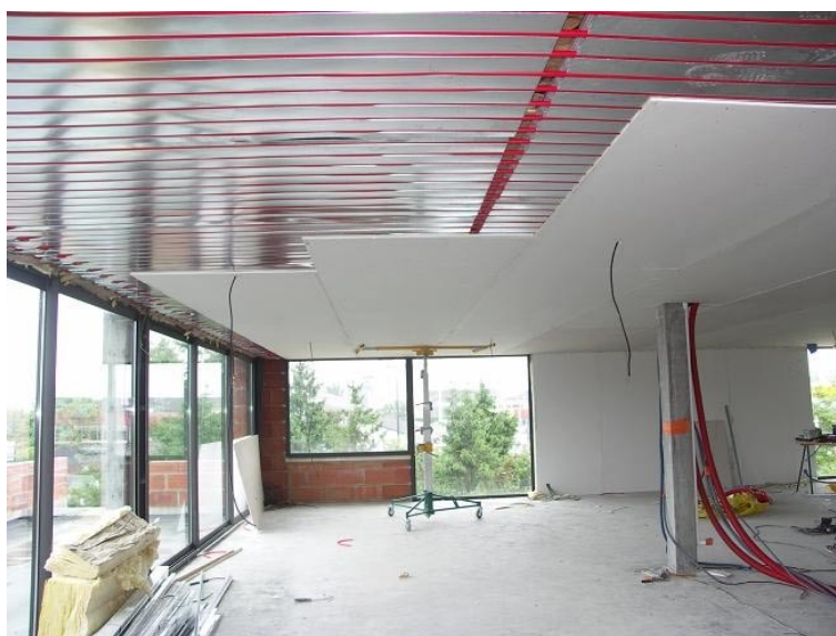
Figure 12 - Exemple de réalisation d'un siège social, chantier réalisé avec le plafond réversible Plafino couplé à une isolation et des plaques de plâtre.
