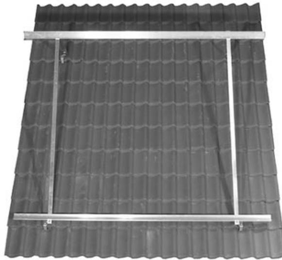
**Figure 3 - Implantation du support capteurs sur la toiture**
