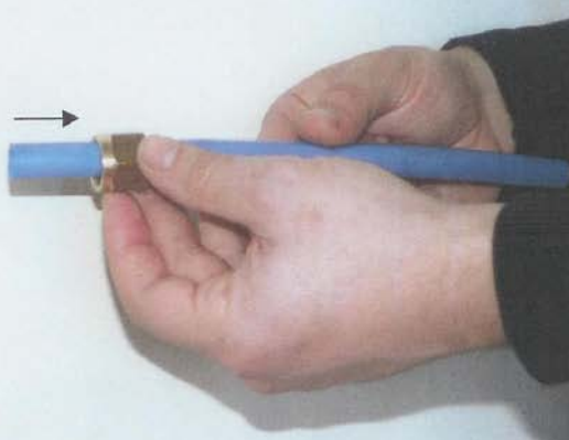
3 ENFONCER L'EMBOÛT EN FORCE SUR UNE SURFACE PLANE
