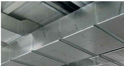
Figure 16 – Réseau de distribution par "conduits isolés"
