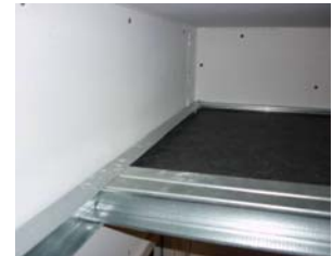
Figure 17 – Réseau de distribution par "plenums"
