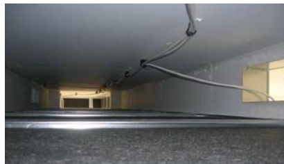
Figure 17 – Réseau de distribution par "plenums"
