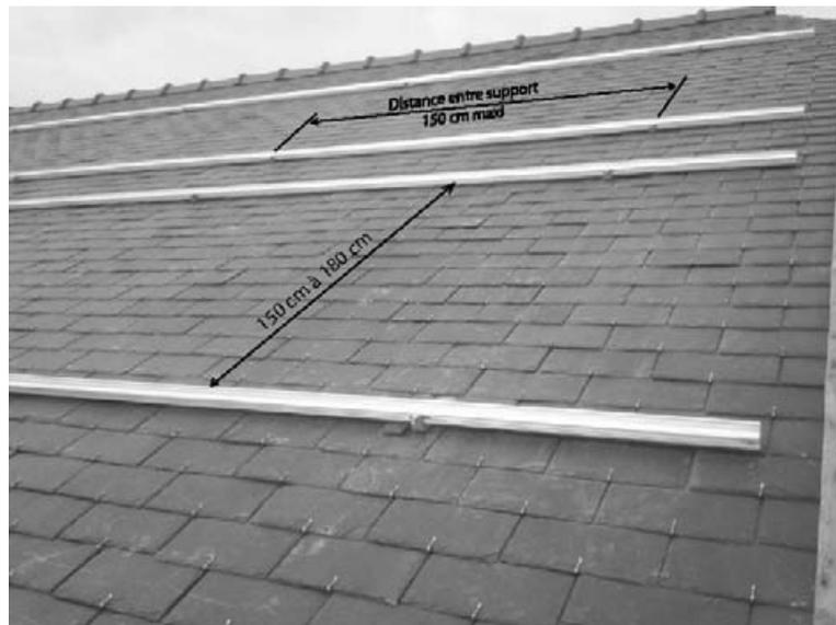
Figure 18 – Exemple de mise œuvre sur toiture inclinée avec couverture en ardoises
