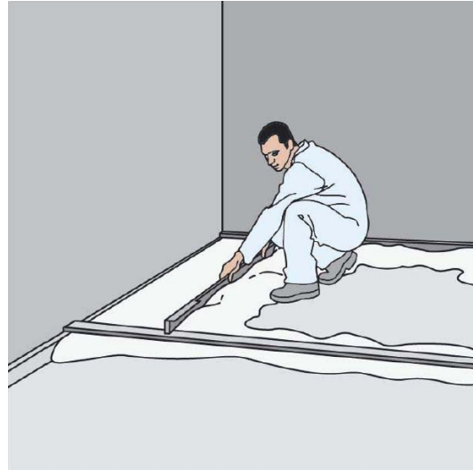
Figure 4 - mise en œuvre du Knauf Forme
