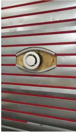
Figure 9 - Dévoiement autour d'un petit obstacle (bouches de VMC) et contournement d'une trappe ou d'une fenêtre de toit. (Sur un banc de formation)
