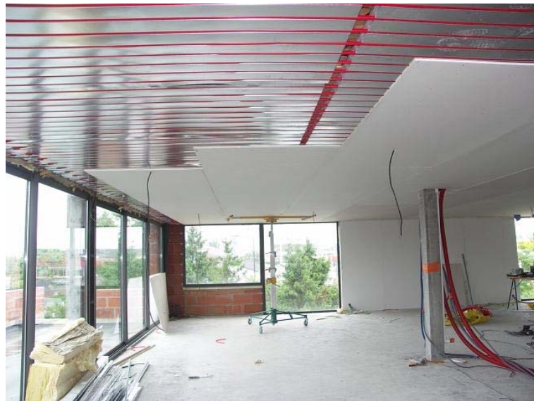
Figure 10 - Exemple de réalisation d'un siège social, chantier réalisé avec le plafond réversible « Système Plafino » couplé à une isolation et des plaques de plâtre.
