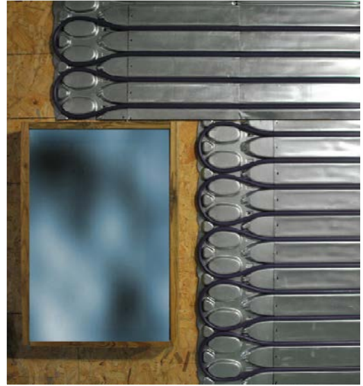
Figure 9 - Dévoiement autour d'un petit obstacle (bouches de VMC) et contournement d'une trappe ou d'une fenêtre de toit. (Sur un banc de formation)
