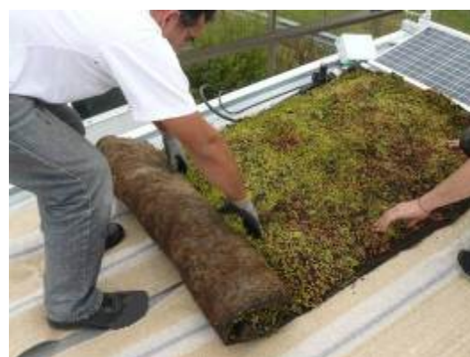
Figure 2a – Pose des tapis de sedum
