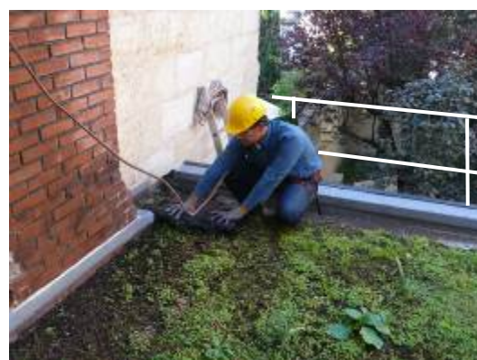
Figure 2b – Pose des tapis de sedum
