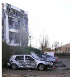
Dégâts dus à l'explosion d'un dépôt de pétrole à Buncefield (Angleterre, 2005). Photo prise à plus de 400 mètres de l'explosion.
