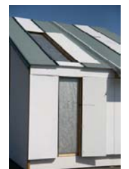
Prototype en cours de construction
