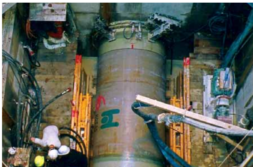
Mise en œuvre d'un tube de fonçage
