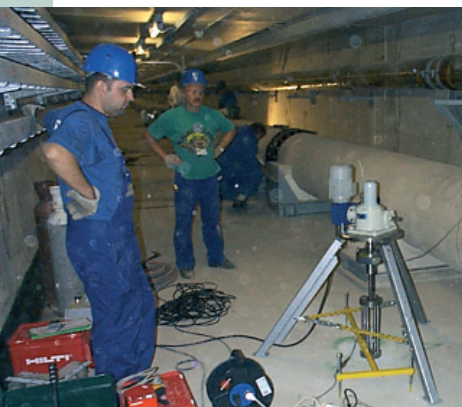
Essais d'arrachement de chevilles en centrale nucléaire
