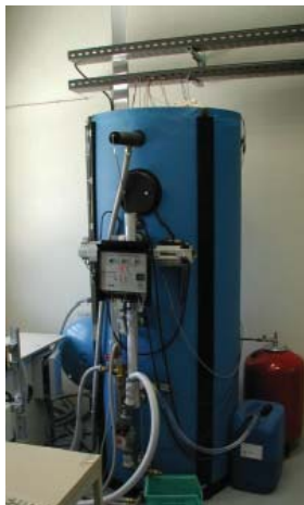
Essais sur un ballon de stockage
