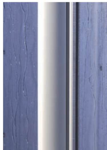
Essai d'étanchéité à l'eau
