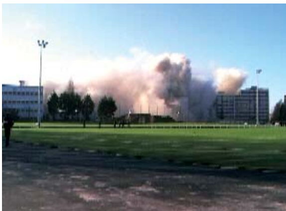
^ Démolition par explosion d'un immeuble du Havre
