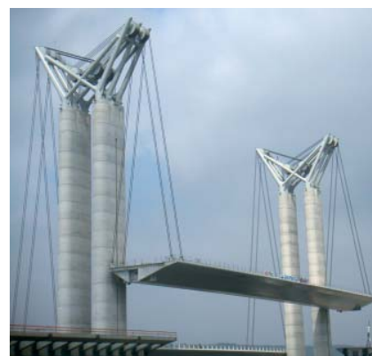
Mesure de vibrations du Pont de Rouen
