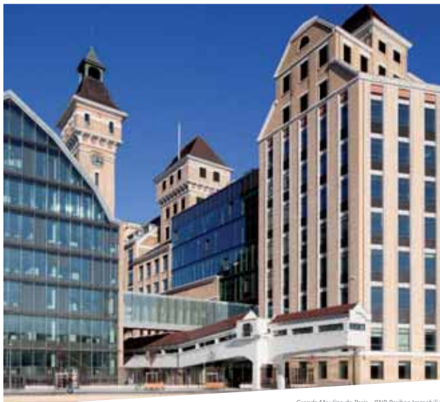
Grands Moulins de Paris - BNP Paribas Immobilier Pantin (93) Architecte : Reichen & Robert et associés - Photo Luc Boegly
