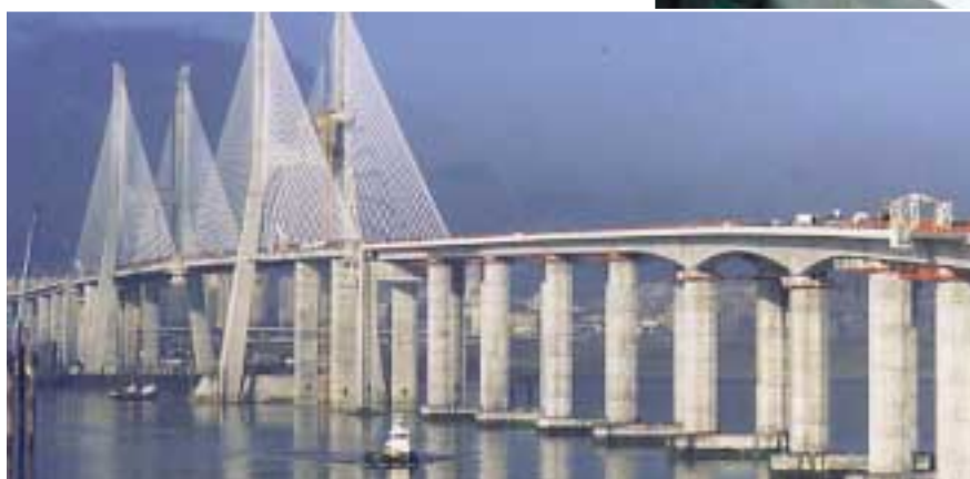
Pont du Tage - Portugal
