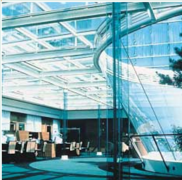
Cité Administrative de Saint-Germain-en-Laye - Architectes : Brunet et Saunier
