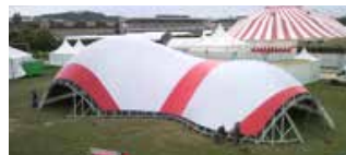
Gridshell pour la structure du Forum Solidays, conçu au Laboratoire Navier.
