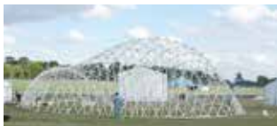
Gridshell pour la structure du Forum Solidays, conçu au Laboratoire Navier.
