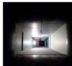
Figure 7 : Essai en vaine de gaine d'un hauban de pont.
