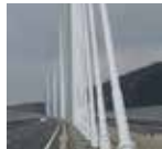
Figure 1 : Haubans de pont (Millau, France).
