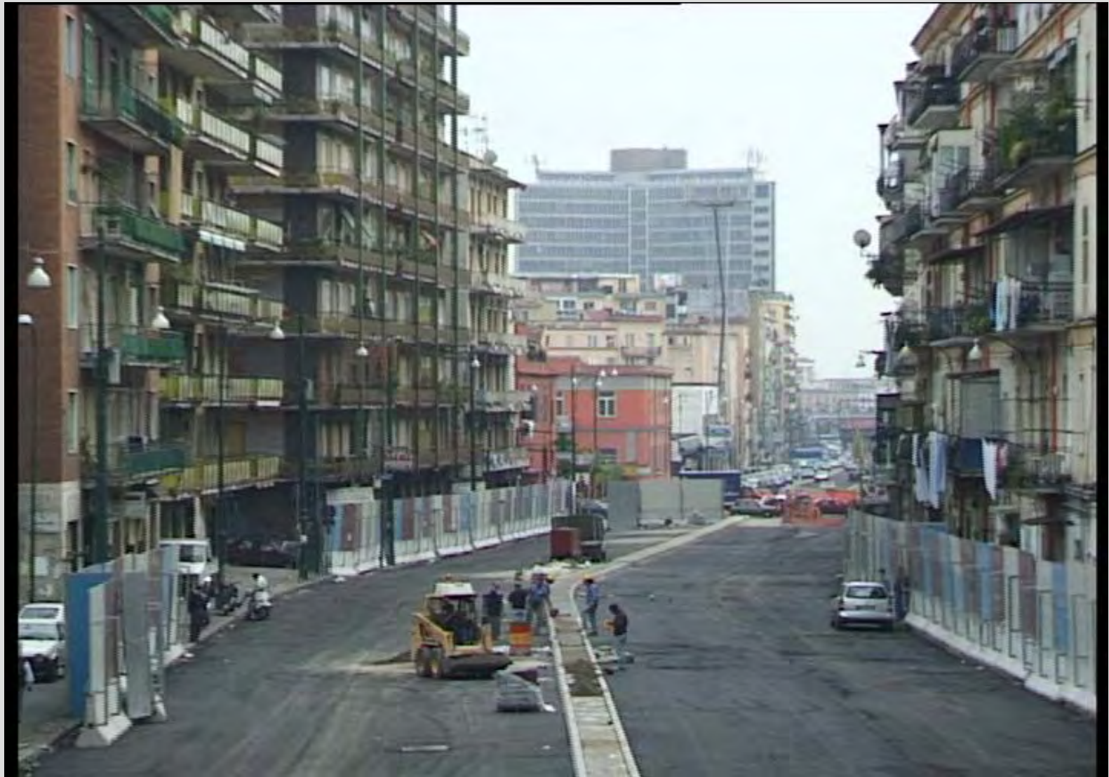
Corso Novara en 2000, tout de suite après la démolition de l'échangeur routier
